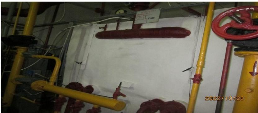
Состояние и внешний вид источника тепловой энергии котел старого образца выработал свой ресурс, системы контроля и управления газом не имеет.
