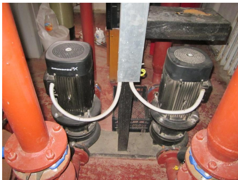
Рисунок: Тепловые насосы котельной № 13
